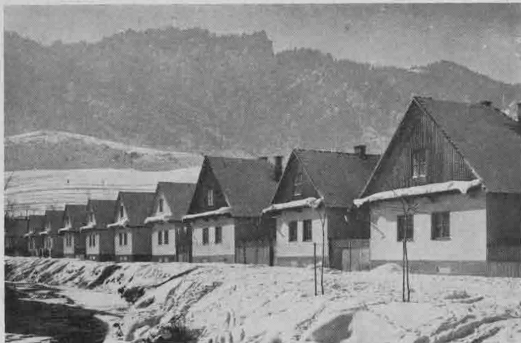
Domoradie realizované v dvojročnicovej výstavbe na základe vypracovaných projektov. Terchová (okr. Žilina). Foto K. Gross.
