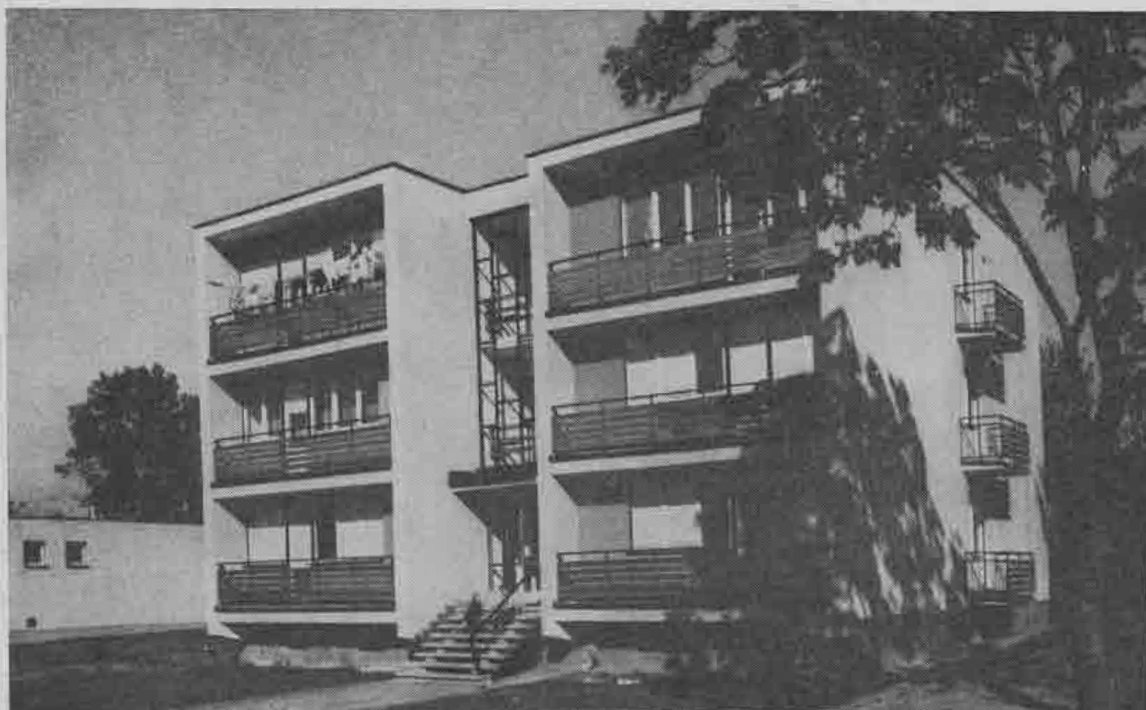
Komunálny šesťbytový dom postavený vo Východnej (okr. Lipt. Mikuláš) zač. 70. rokov vychádza z projektu hromadnej výstavby určeného pre horské oblasti.
